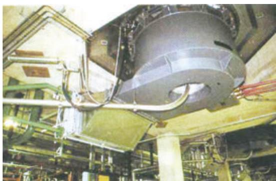
Ce transformateur, fabriqué en Belgique alimente un groupe de vingt de ces moteurs, de **3400 kW** chacun, (**4500 chevaux**) Soit **68000 kW** au démarrage.
