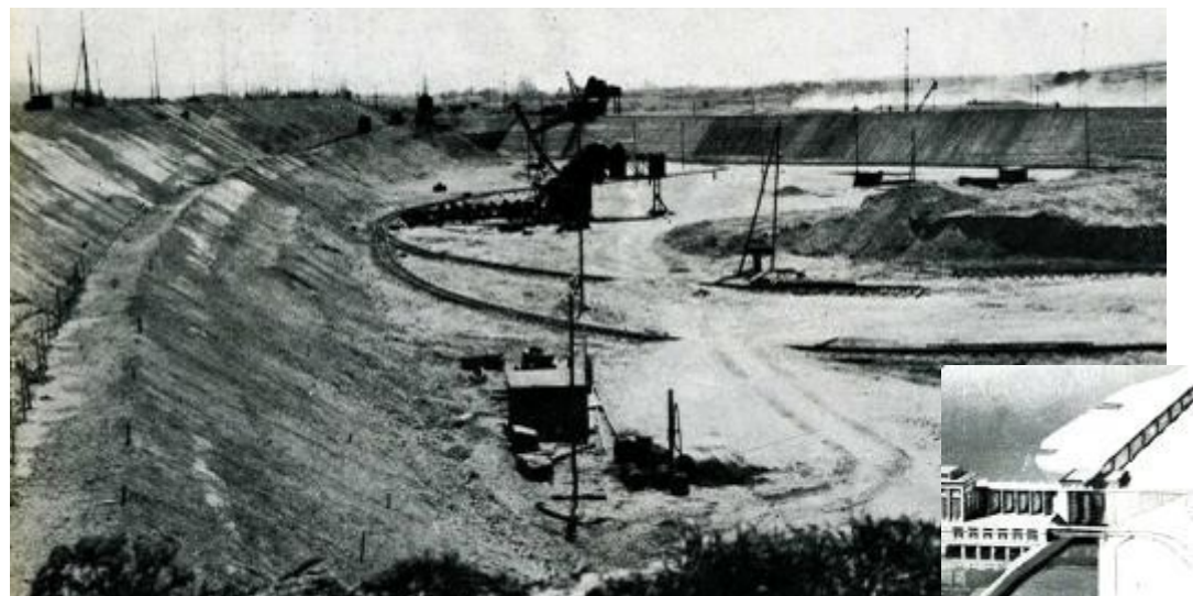
Chantier « COEHBA » vue du belvédère de St Pierre
